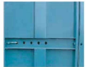
L'assemblage des 4 panneaux à l'aide de clavettes cadmiées s'effectue rapidement. Le bouchon de fermeture sert à obturer les trous inutilisés.
