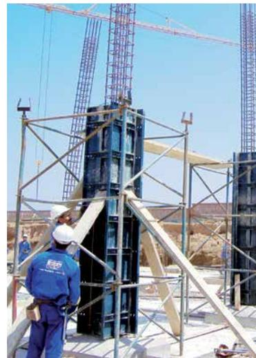
Ils autorisent aussi une adaptation flexible à la section du poteau allant de 0,20 m jusqu'à 0,45 m avec un pas de 5 cm.
